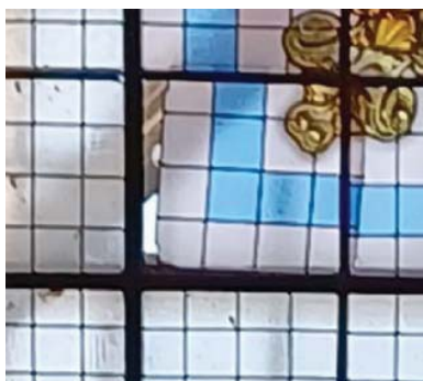
Plafón descolocado por viento
